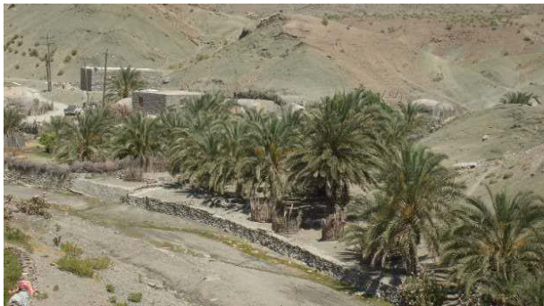
شکل ۱: در بند و کش بند از دسته ساره‌های سنتی بومیان هزمزگانی میباشد که بترتیب بصورت دیواره عمود بر امتداد جریان و بصورت سیل بند جهت جفاظت و ایجاد بستر کشت و حفظ رطوبت در حاشیه رودخانه احداث میشوند
