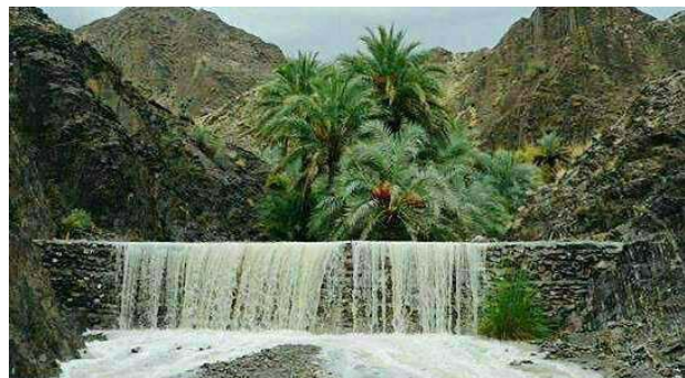
شکل ۱: در بند و کش بند از دسته ساره‌های سنتی بومیان هزمزگانی میباشد که بترتیب بصورت دیواره عمود بر امتداد جریان و بصورت سیل بند جهت جفاظت و ایجاد بستر کشت و حفظ رطوبت در حاشیه رودخانه احداث میشوند
