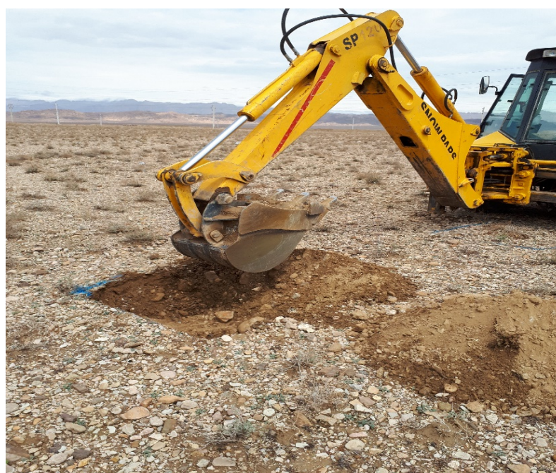
شکل ۲- حفر گودال توسط بیل مکانیکی به منظور قرار دادن تشت تبخیر کلرادو
