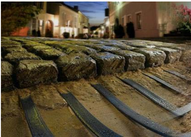
شکل ۱۲- سیستم ذوب برف الکتریکی
