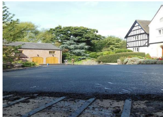
شکل ۱۲- سیستم ذوب برف الکتریکی
