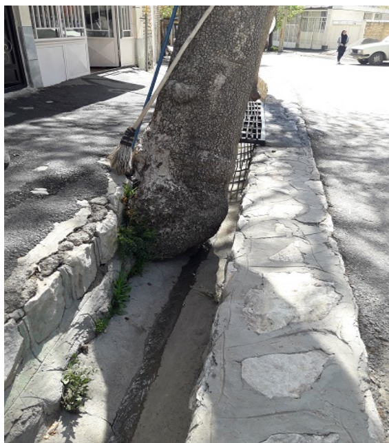
شکل ۲- نمونه‌هایی از انسداد مجاری انتقال رواناب سطحی در شهر فریدونشهر
