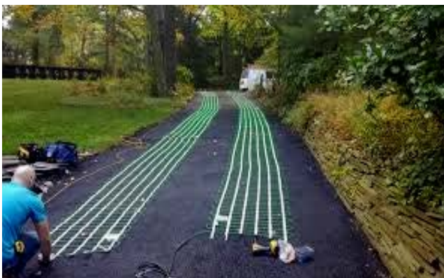
شکل ۱۱- نصب تشک ذوب یخ و برف زیر بستر جاده
