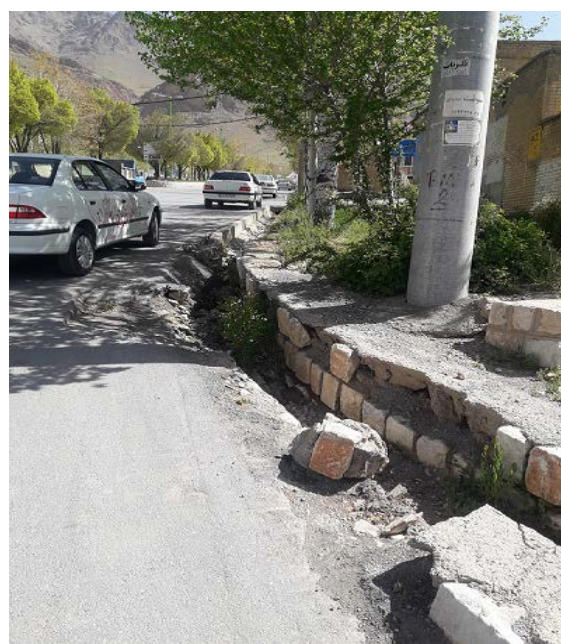
شکل ۲- نمونه‌هایی از انسداد مجاری انتقال رواناب سطحی در شهر فریدونشهر
