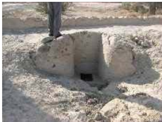
شکل ۴: دریچه‌های کنترل احداث شده در بین بندها
