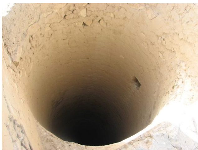
شکل ۵: نمایی از داخل چاه تغذیه‌ای و دریچه ورود آب به داخل چاه، دیواره از سنگ و ساروج
