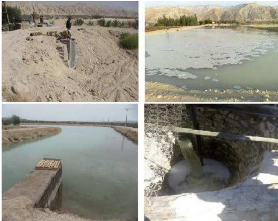
شکل ۷: بندآب ذخیره سیلاب قبل از تزریق به چاه نزو و نمایی از دریاچه ورودی آب به داخل چاه نزو ( اجرا شده توسط آقای سید عبدالقادر حسینی گزیر ( عکس ها از حسینی، چوپانی و حسین پور))
