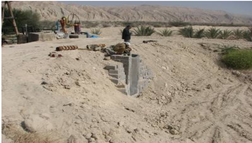
شکل ۱۱: نمایی از دریچه ورودی آب به چاه، که بوسیله توری گالوانیزه با مش های نسبتاً کوچک مهار شده است.
