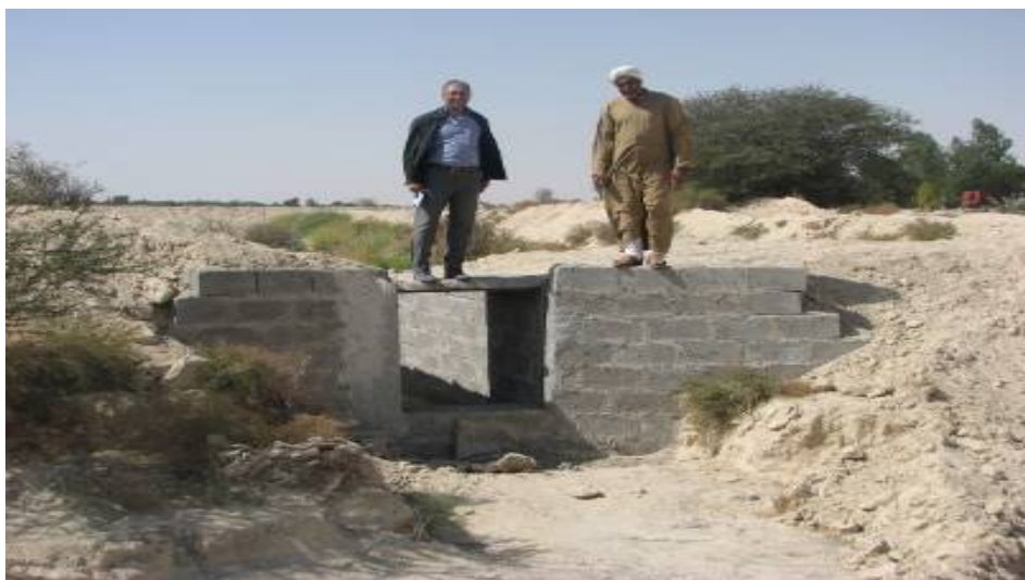
شکل ۸: نمایی از دهانه ورودی استخر تغذیه
