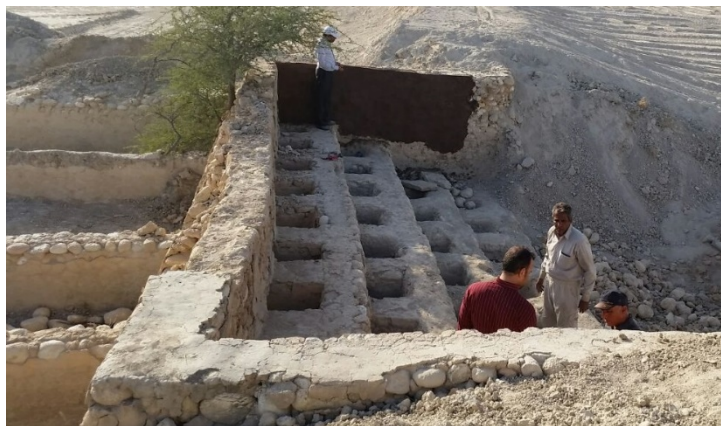
شکل ۲: نمایی از علگه و دریچه‌های تقسیم آب در سطوح مختلف آبیگری
