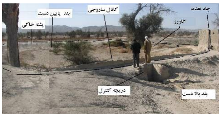
شکل ۶: نمایی از یک بند همراه با کلیه قسمت‌های یک سیستم تیربند (خط چین محدوده آبیگر یا بند نشان می‌دهد)
