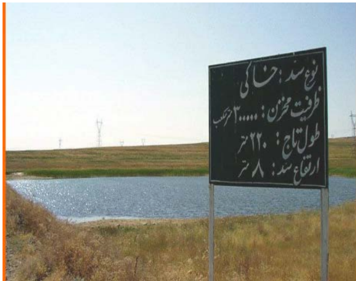
شکل ۲- احداث بند خاکی در مسیر آبراهه اصلی جمع‌آوری روان‌آب مراتع
