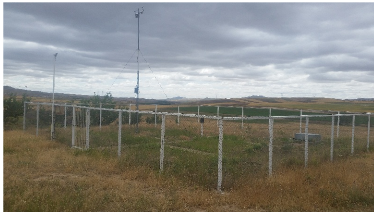
شکل ۴- احداث ایستگاه هواشناسی
