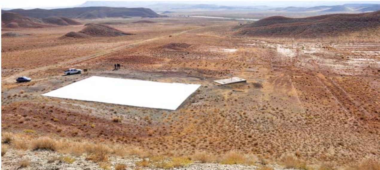
شکل ۸: تصویری از سطح عایق احداث شده برای جمع‌آوری آب باران و استخر سر پوشیده (مخزن بتونی) در پایین دست سطح عایق با حجم ۲۸ متر مکعب در ایستگاه تحقیقات حفاظت خاک و آبخیزداری خواجه
