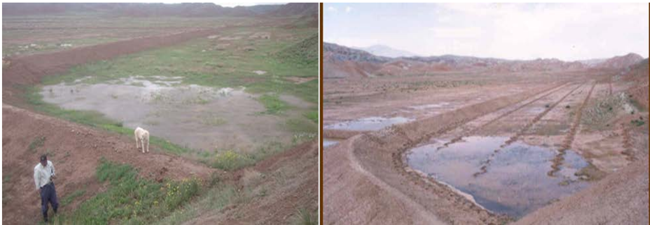
شکل ۹: نمایی از کنتر باند احداث شده در پای دامنه در ایستگاه تحقیقات حفاظت خاک و آبخیزداری خواجه و عملکرد آنها در استحصال رواناب و افزایش پوشش گیاهی (سه سال بعد از اجرای عملیات)
