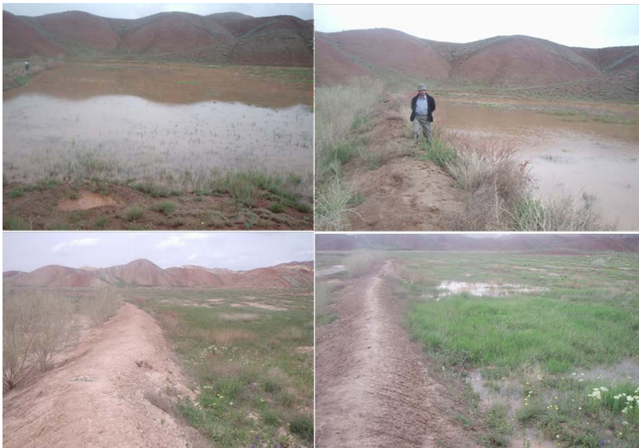
شکل ۱۰: نمایی از کنتر ترنج‌های احداث شده در ایستگاه تحقیقات حفاظت خاک و آبخیزداری خواجه و عملکرد آنها در استحصال رواناب و افزایش پوشش گیاهی در منطقه (سه الی چهار سال بعد از اجرای عملیات)
