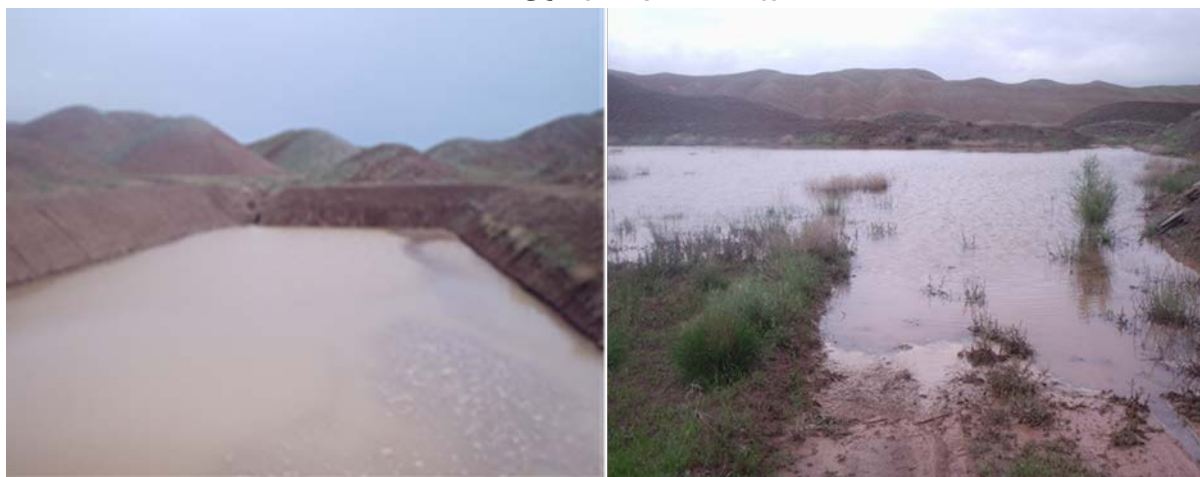
شکل ۱۲: نمایی از میکروکچمنت‌ها (بانکت‌های هلالی) احداث شده در ایستگاه تحقیقات حفاظت خاک و آبخیزداری خواجه و عملکرد آنها در استحصال رواناب و افزایش پوشش گیاهی منطقه (سه سال بعد از اجرای عملیات)
