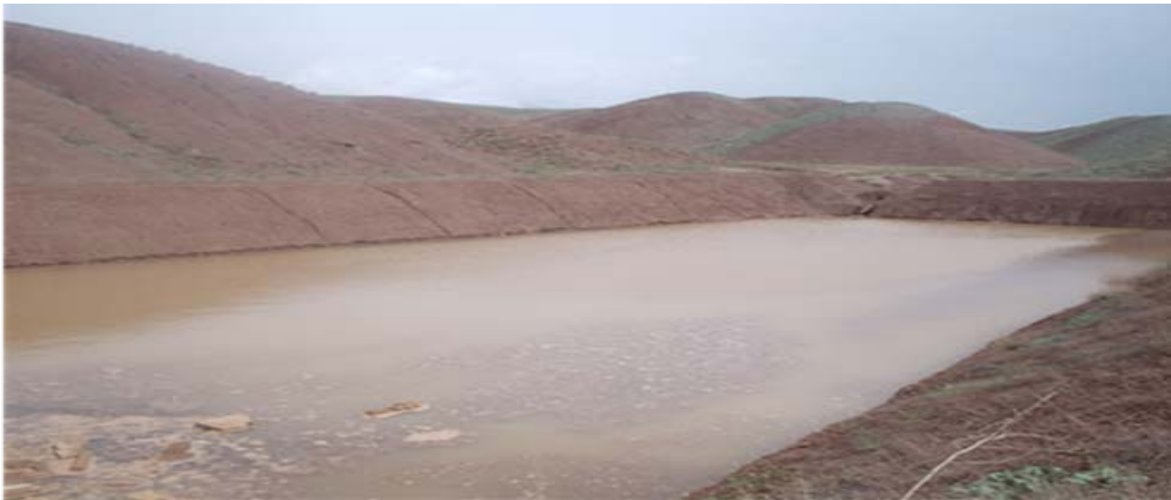
شکل ۷: تصویری از حوضچه‌های ذخیره آب و رسوب (استخر خاکی) احداث شده در ایستگاه تحقیقات حفاظت خاک و آبخیزداری خواجه (سال ۱۳۷۶)
