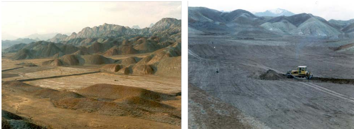
شکل ۵: تصاویری از کنتور ترنج‌های احداث شده در ایستگاه تحقیقات حفاظت خاک و آبخیزداری خواجه (سال ۱۳۷۳-۱۳۷۵)
