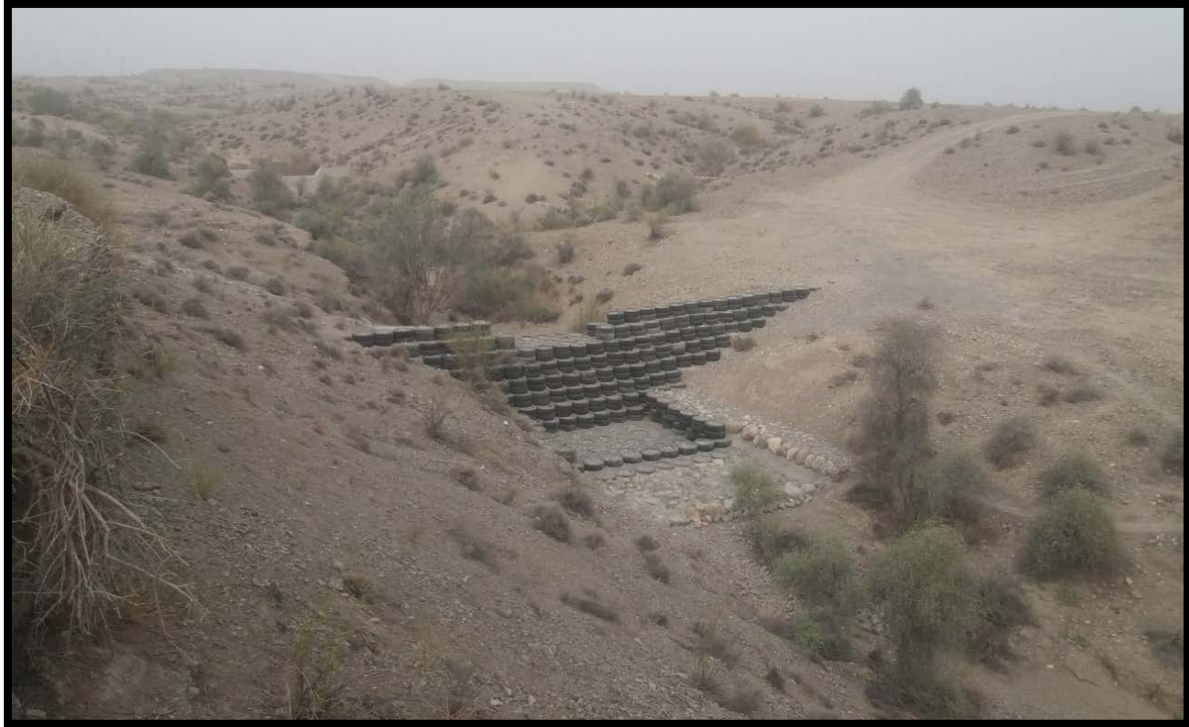
شکل ۲ - اجرای طرح سازه لاستیکی در حوزه آبخیز معرف و زوجی دهگین
