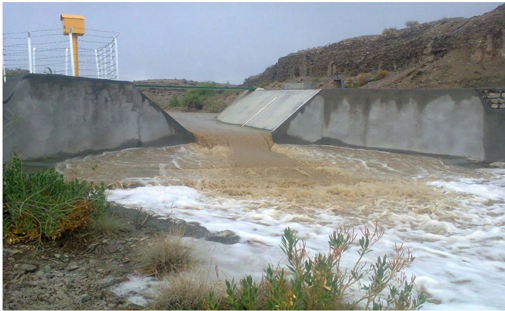
شکل ۴- فلوم اندازه گیری سیلاب در خروجی حوزه شاهد
