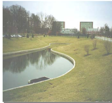
شکل (۴) - احداث مخازن (Ponds) بصورت طبیعی یا مصنوعی برای نگهداشت آب
