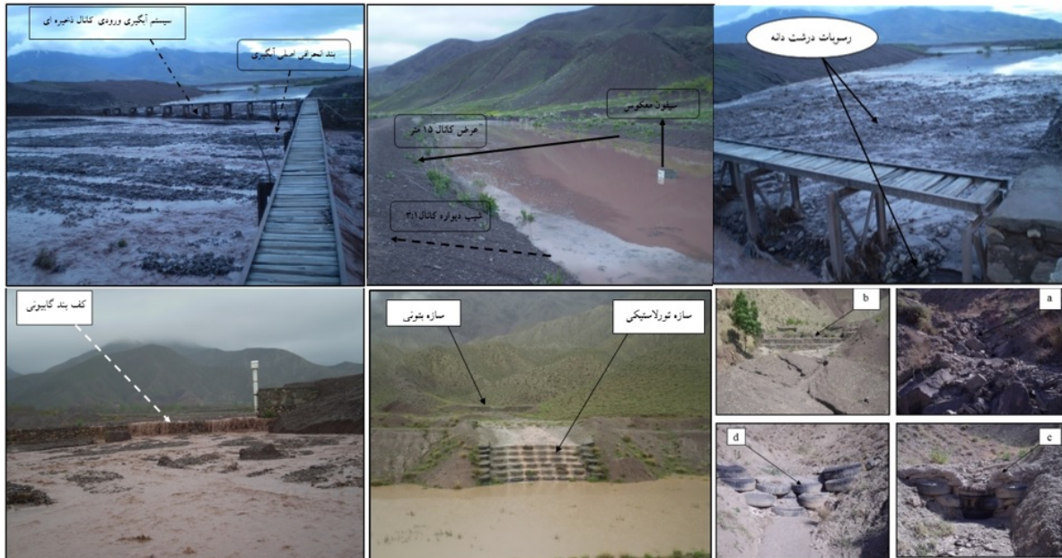
شکل (۲) - نمایی از انواع سازه های آبی در ایستگاه پخش سیلاب بر آبخوان تسوج
