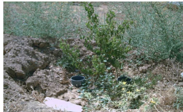
شکل ۴- فیلترهای سنگریزه نصب شده در کرت‌ها
