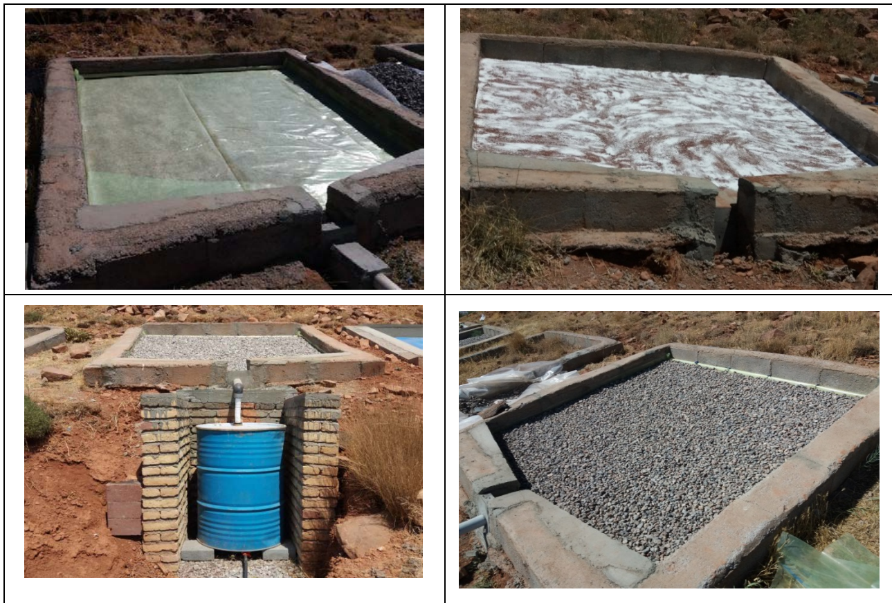
شکل ۳- مراحل اجرایی ساخت سطح آبیگر با پوشش نایلون گلخانه‌ای دارای محافظ شنی
