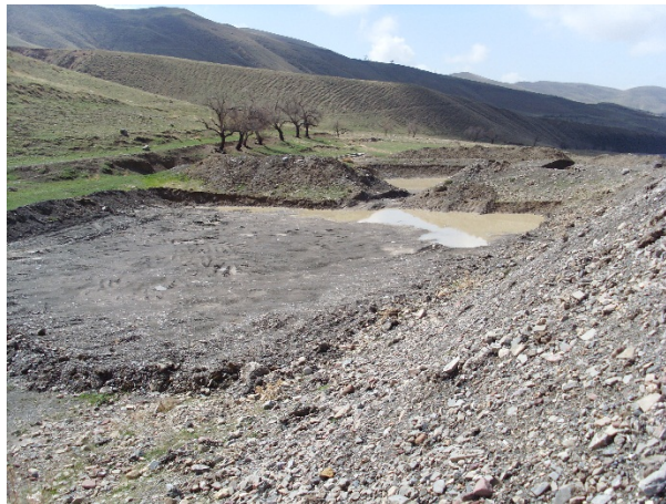
شکل ۶- عملیات اجرایی تورکینست شماره ۲ در حوزه آبخیز مشنق
