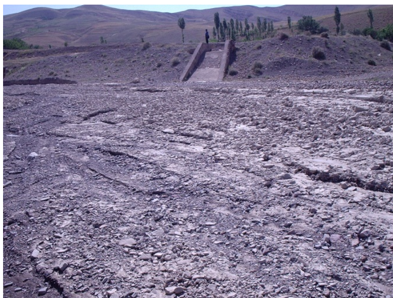
شکل ۵- احداث سرریز در پایاب تورکینست
