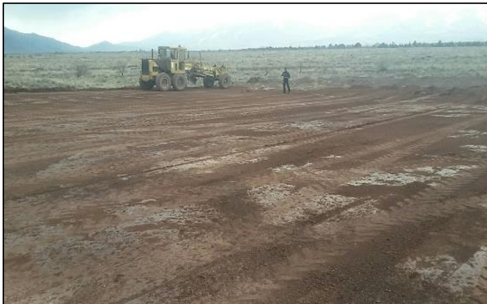
شکل ۱- تسطیح سطح سامانه عایق در محل آبخیزداری تسوج
