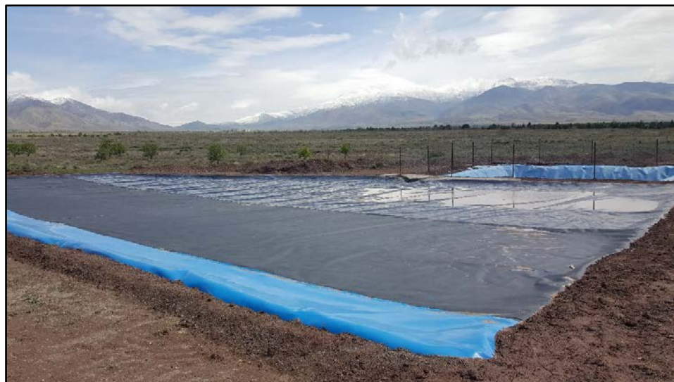
شکل ۲- استفاده از ژئوممبران برای عایق نمودن سطح سامانه و استخر ذخیره آب
