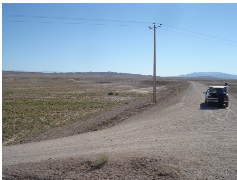
شکل ۴: وضعیت عدم آبیگری مخزن سازه خاکی شوراب خلیل‌آباد
