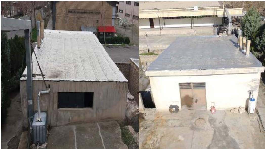
شکل ۲- سامانه استحصال آب باران از پشت‌بام موتورخانه
