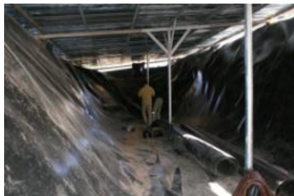
شکل ۷- نمای مخزن و عملیات ستون گذاری
