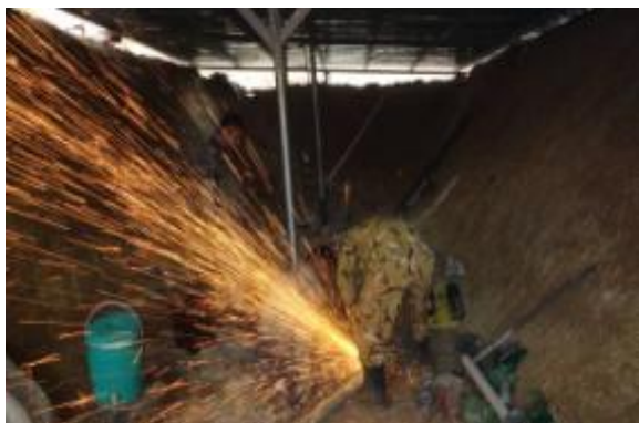
شکل ۸- نمای درون مخزن و نصب ژئوممبران
