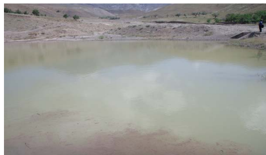
شکل ۷- تصویر احداث تورکینست در کنار رودخانه، بالادست مادر چاه قنات
