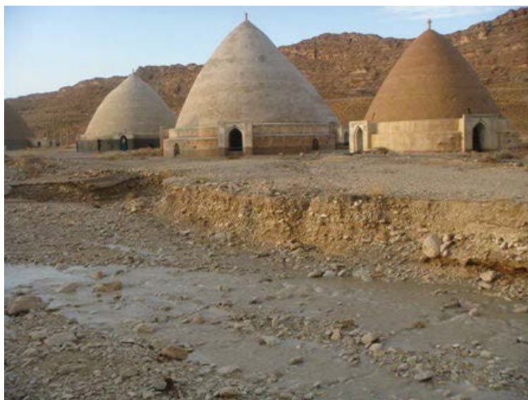
شکل ۲- برکه باران در حاشیه آبراهه اصلی برای بهره برداری از سیلاب
