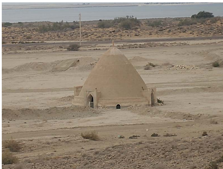
شکل ۱- برکه باران در انتهای خشکه رود با خاکریز خاکی هدایت آب به مخزن
