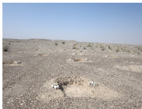
شکل ۱- نمایی از سامانه ذخیره نزولات چاله فلسی
