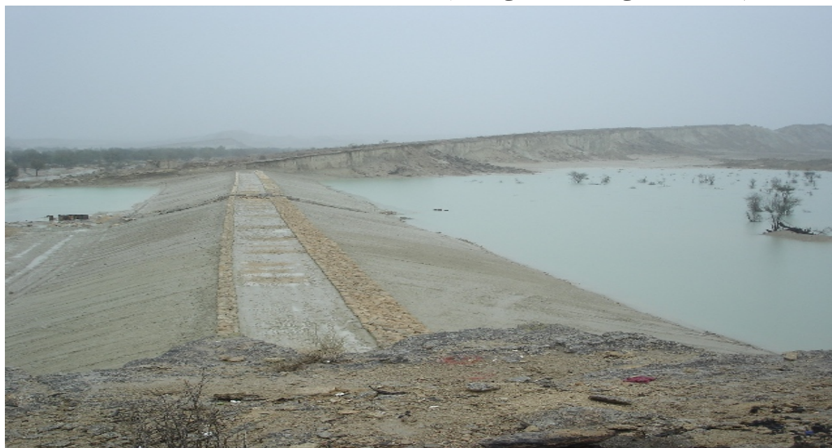
شکل ۲- نمونه ای از چشک های احداث شده در طرحهای آبخیزداری جزیره قشم
