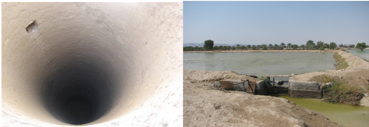
شکل شماره ۴ - نمایی از درون چاه نزو با دیواره سنگ و ساروج و دریچه ورود آب به داخل چاه
