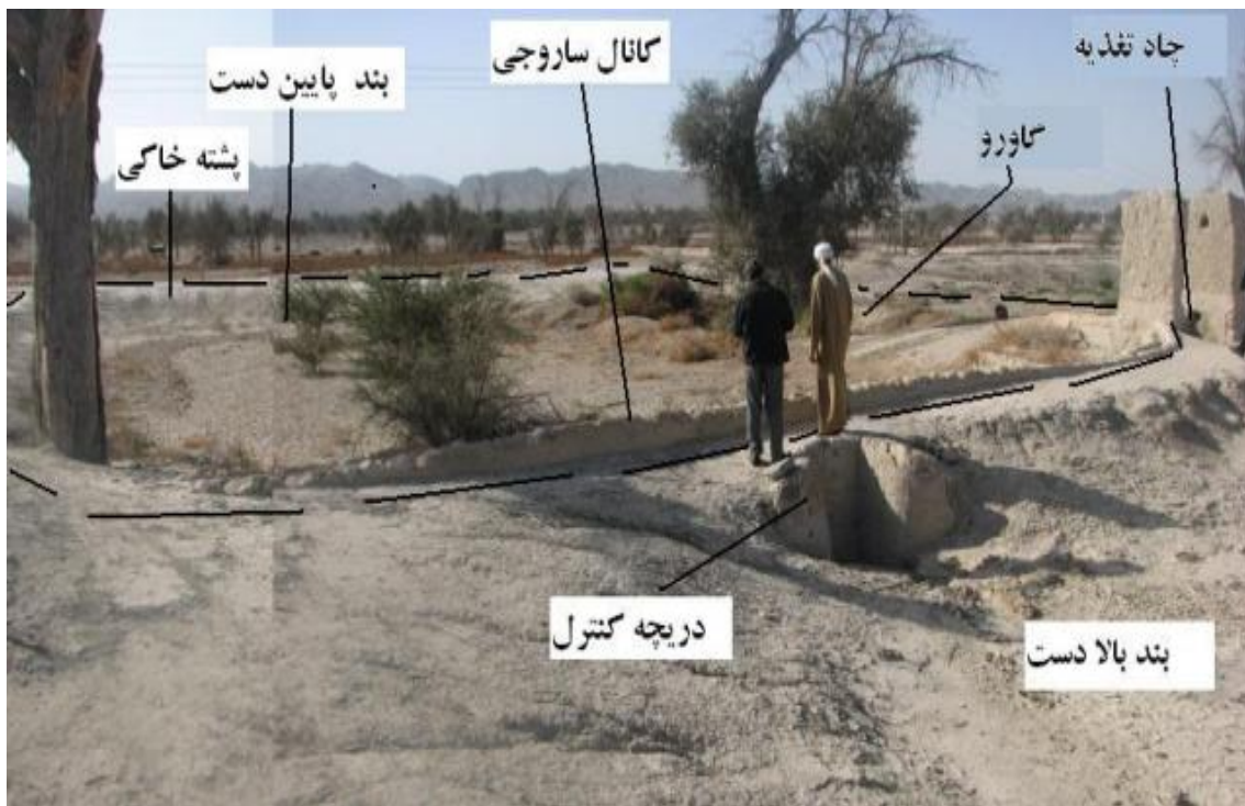
شکل شماره ۳- اجزای سیستم چاه نزو
